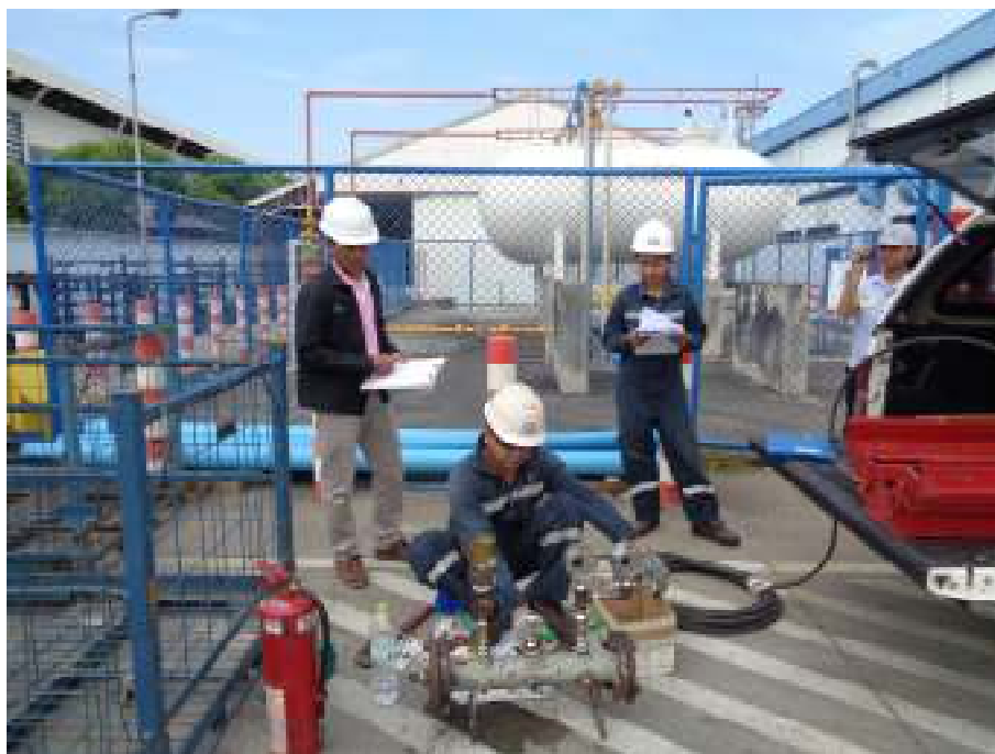
รูปภาพที่ ๒ : พนักงานเจ้าหน้าที่สำนักงานพลังงานจังหวัดฉะเชิงเทรา ออกตรวจมาตรฐานความปลอดภัย สถานที่เก็บรักษาก๊าซปิโตรเลียมเหลว ประเภทสถานที่ใช้ (ถังเก็บและจ่ายก๊าซ)
