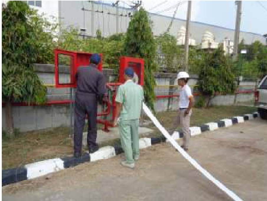
รูปภาพที่ ๑ : พนักงานเจ้าหน้าที่สำนักงานพลังงานจังหวัดฉะเชิงเทรา ออกตรวจมาตรฐานความปลอดภัย สถานที่เก็บรักษาก๊าซปิโตรเลียมเหลว ประเภทสถานที่ใช้ (ถังเก็บและจ่ายก๊าซ)
