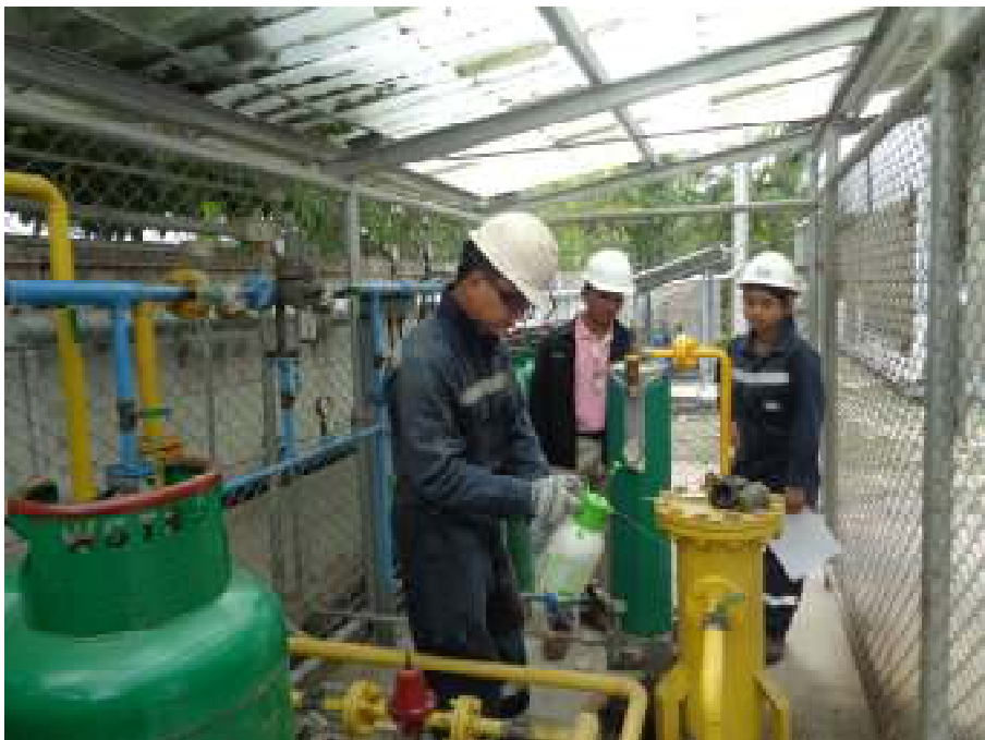
รูปภาพที่ ๔ : พนักงานเจ้าหน้าที่สำนักงานพลังงานจังหวัดฉะเชิงเทรา ออกตรวจมาตรฐานความปลอดภัย สถานที่เก็บรักษาก๊าซปิโตรเลียมเหลว ประเภทสถานที่ใช้ (ถังก๊าซปิโตรเลียมเหลวหุงต้ม)
